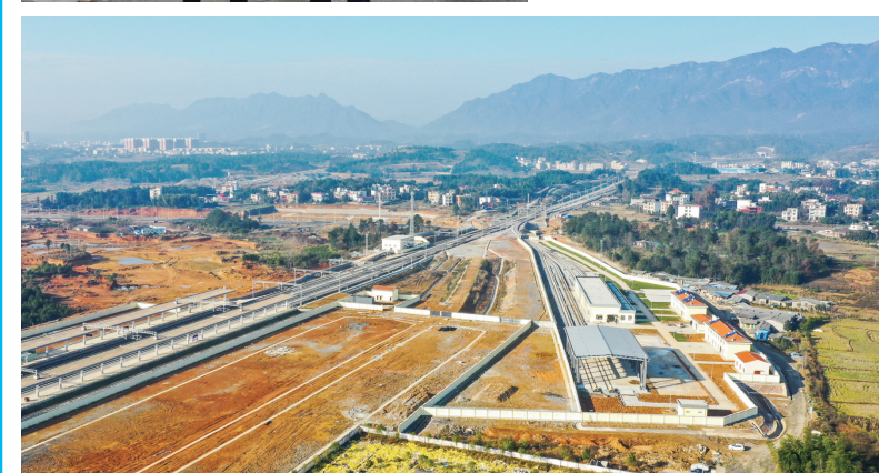
正在修建中的货运站。 申兴刚 摄
