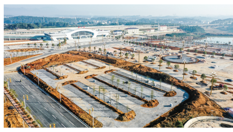
加紧施工中的洞口火车站站前广场。 申兴刚 摄
