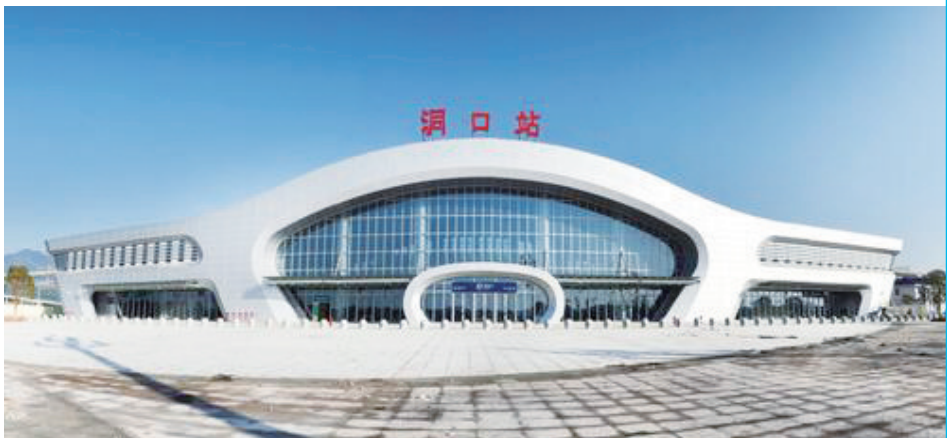
怀邵衡铁路洞口站。 申兴刚 摄
