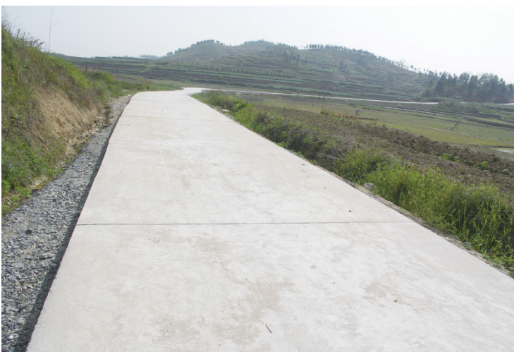
通往小塘镇渡头桥村的通村公路宽阔平坦。通讯员 李进锋 摄
