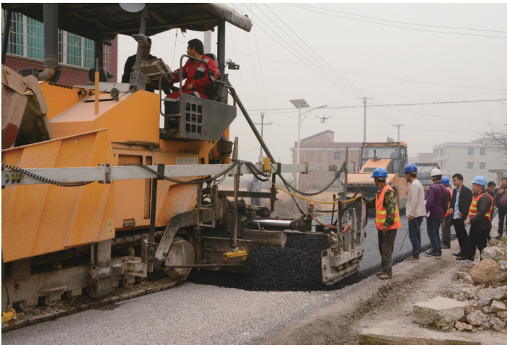
新邵县黄高线改造施工现场。邵阳日报记者 刘波 摄
