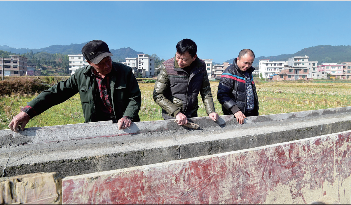
11月26日,隆回县人大代表、石门镇金潭村委员会主任魏文军(中)在检查水渠工程质量。今年,魏文军通过提建议争取资金对水渠进行维修加固,解决了500多亩农田水利灌溉问题,让农民种植水稻旱涝保收。 贺上升 摄
