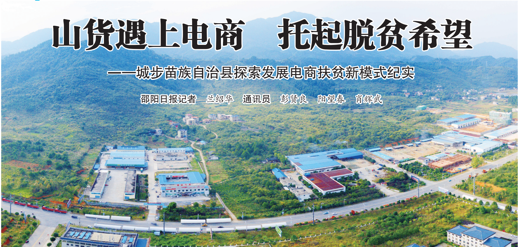
▲正在建设中的城步电商物流园。 邵阳日报记者 申兴刚 摄
