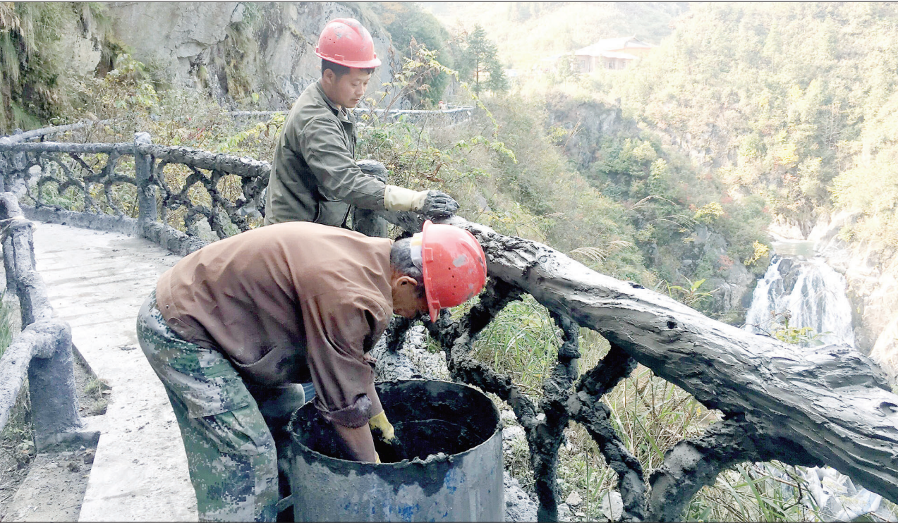
10月26日,隆回县小沙江镇旺溪瀑布景区施工人员正在加固游步道仿生栏杆。目前,该景区正在进行游步道、仿生栏杆等基础设施的改造和维修,并规划建设玻璃栈道和玻璃观景台等配套设施,着力打造3A级旅游景区。 邵阳日报记者 杨敏华 通讯员 贺上升 摄影报道
