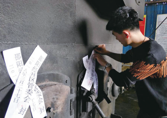
▲环保执法人员对已经废弃的燃煤锅炉粘贴封条。
