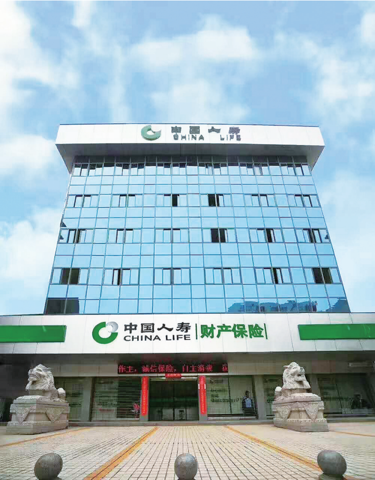
中国人寿财险邵阳市中心支公司办公大楼
