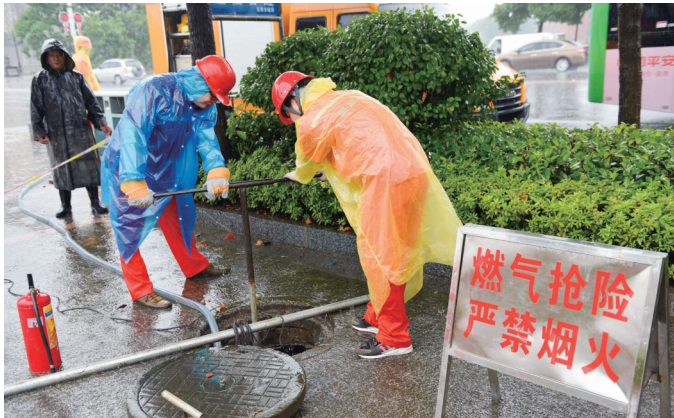
邵阳燃气职工冒雨抢修管道。
