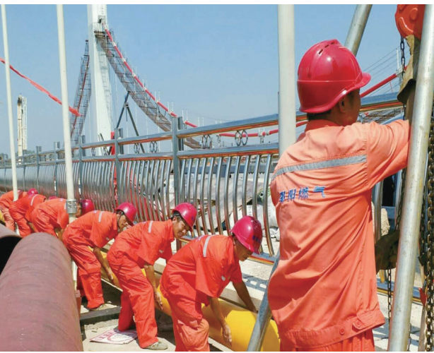
市区资江桂花大桥燃气主管过桥项目施工现场。
