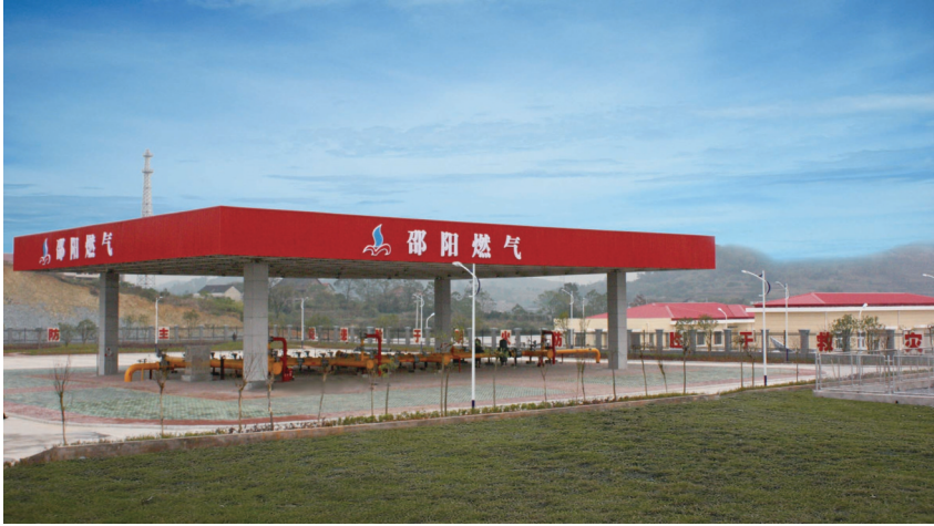
邵阳燃气门站
