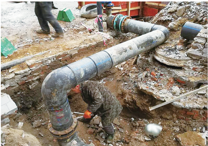
1月26日,新邵县自来水公司对人防工程水管改造进行加班加点施工,以应对冰冻天气。石世桢 郭立敏 摄影报道
