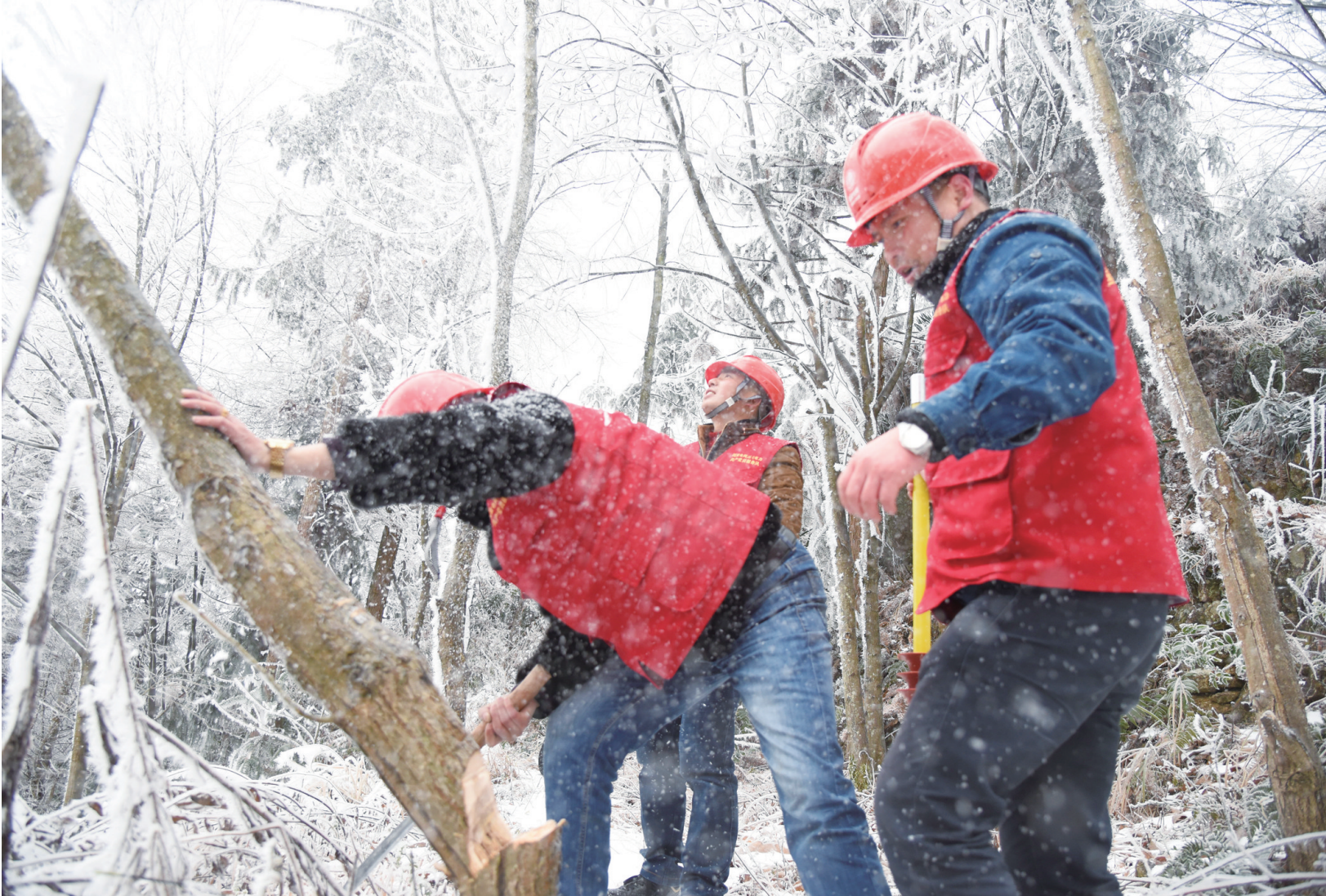
国网隆回县供电公司全面启动“防冻融冰”应急预案,组织工作人员积极奋战在抗冰保电最前沿,全面打响抗冰保电攻坚战。图为电力共产党员服务队在大水田乡司钡线白马山支线进行线路巡视及砍青扫障工作。 刘 萍 摄
