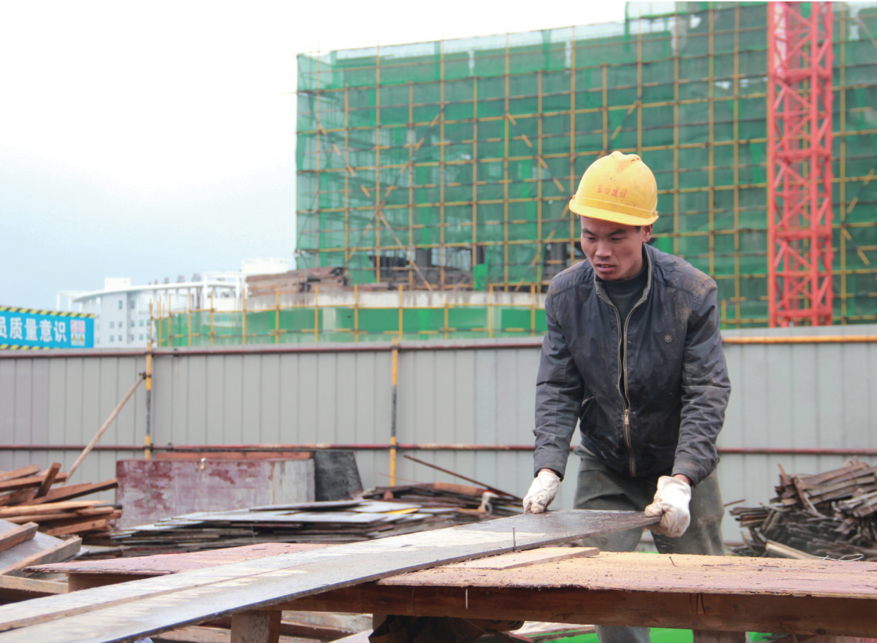
1月4日中午,施工人员正在市一中搬迁项目建筑工地上切割板材。
