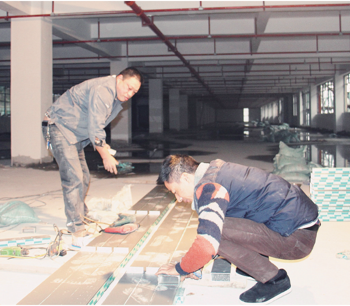
12月8日,位于邵阳经济开发区内的中国(中部)快时尚产业金砖谷特色小镇一期——宝丰国际服装箱包产业城的11栋标准厂房正在进行内部装修。下个月,已经签约的二十多家企业将陆续入园投产。 童中涵 摄
