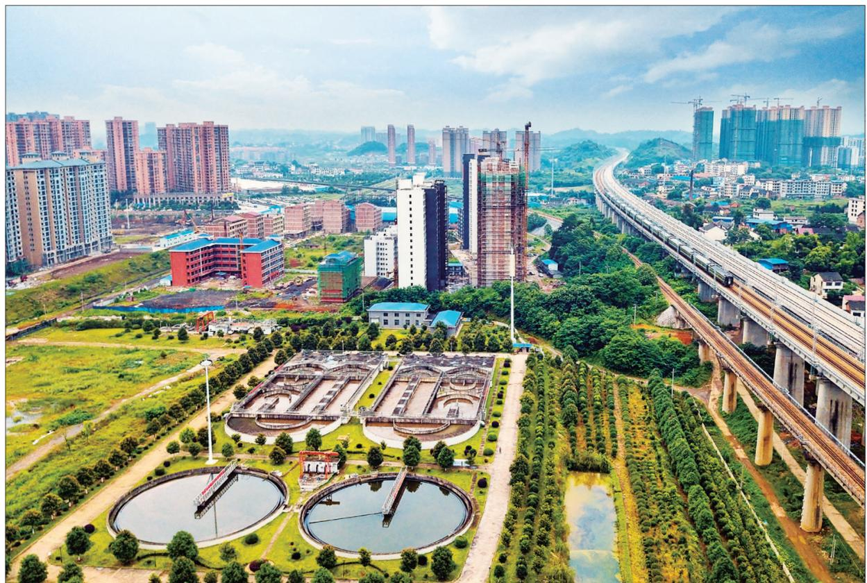
7月15日，正在运行的市区红旗渠污水处理厂。目前，该污水处理厂铺设截污干管22.276公里，管网覆盖红旗河沿岸两侧的新建居住区及工业开发区，包括余湖山新城、紫薇博览园、白马工业基地等，污水处理规模为每天4万立方米。
