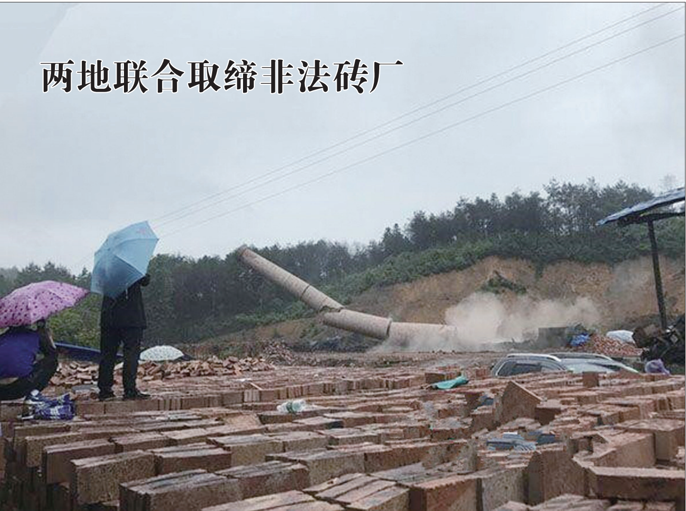
6月26日,武冈市与新宁县两地国土资源、安监等职能部门开展联合整治行动,雇请专业爆破公司,对白莲江砖厂烟囱实施定点爆破。 白莲江砖厂位于武冈市司马冲镇和新宁县万塘乡交界处,存在无采矿许可证、安全生产许可证开采及违规排污等行为。为杜绝非法生产,规范矿业秩序,工作人员多次上门和当事人协商。近日,当事人同意自行拆除砖厂主体及工棚。随后,两地相关部门组织专门力量,对高达几十米的烟囱实施爆破拆除。图为爆破烟囱现场。 周维标 刘传 肖爱良 摄影报道
