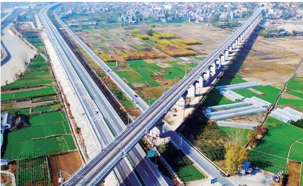
兰渝铁路陇南境内的王白龙江特大桥(上)与高速公路交错。新华社发
