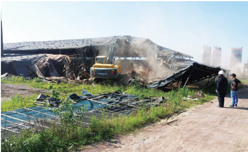
隆回县国土资源执法监察中队在拆除非法粘土砖厂。郭常春 摄
