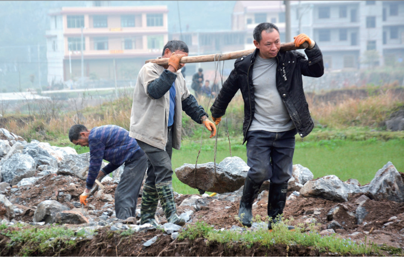
3月29日,施工人员正在新邵县寸石镇武桥村砌筑河堤。武桥村是市委办的联点扶贫村,去年,市委办协调落实农业综合开发资金100余万元,加固全长为700米河堤,为粮食生产打下坚实的基础,工程于去年11月动工,将于今年4月完工。 杨敏华 杨能广 石健康 摄影报道
