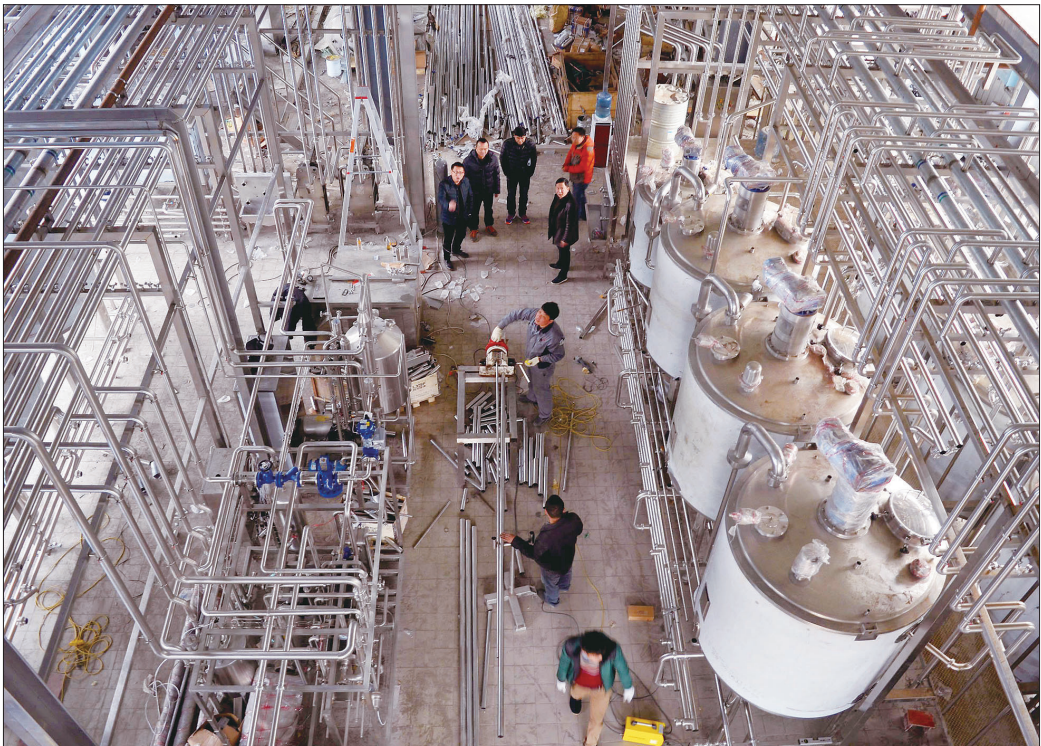
2月15日，湖南南山(城步)牧业有限公司，技术人员在加紧安装新的低温奶生产线。今年，该公司投资8500万元，新扩建5条乳品生产线，力争实现新增产值3亿元以上。
