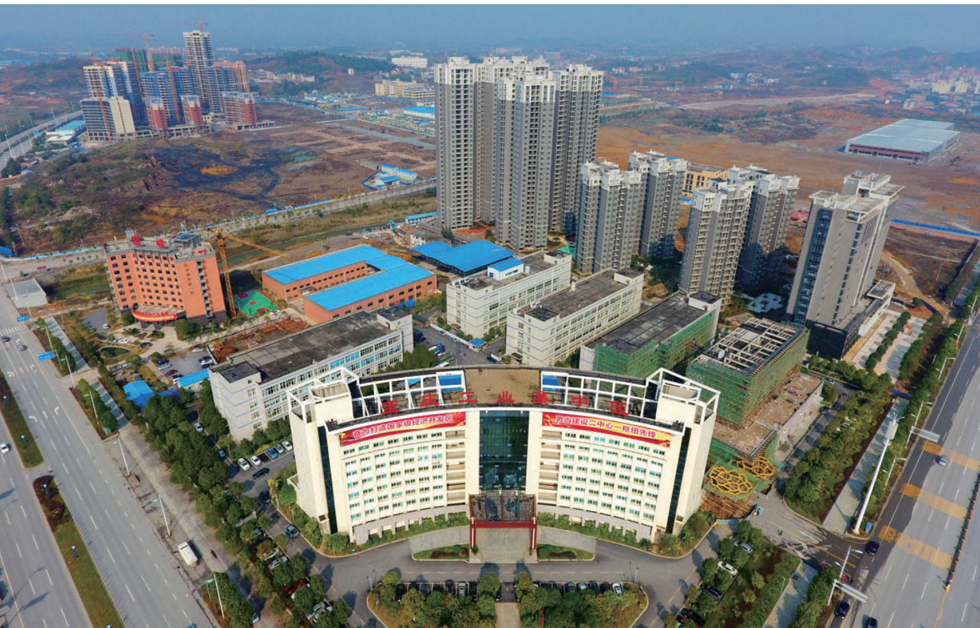
去年底,省政府下文批准同意宝庆工业集中区与邵阳经济开发区(北塔区)合并统称邵阳经济开发区,两个园区四至范围不变,机构编制按权限和程序报批。图为建设中的经开区。
