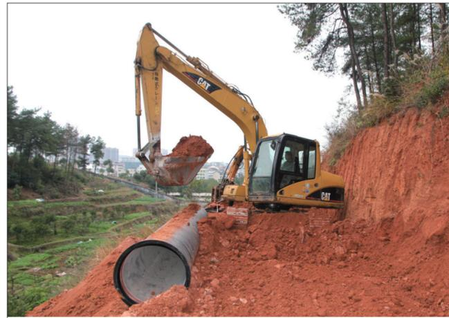
1月6日,新邵县枫树坑水库引水工程配套管网工程正在埋管网。据悉,该引水工程是该县重点民生工程,项目被列入我市重点工程和湖南省2014至2016“两供两治”设施建设项目。项目概算投资2.5亿元,建设周期2年,届时将彻底解决新邵县城12万居民及雀塘产业园区和周边群众的饮水难问题。
