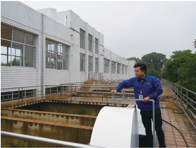
11月25日,制水人员在检查虹吸装置,确保制水设备正常运行。 杨橙 摄
