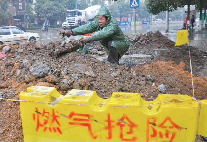
燃气抢修人员在市区宝庆中路附近施工。 申兴刚 摄
