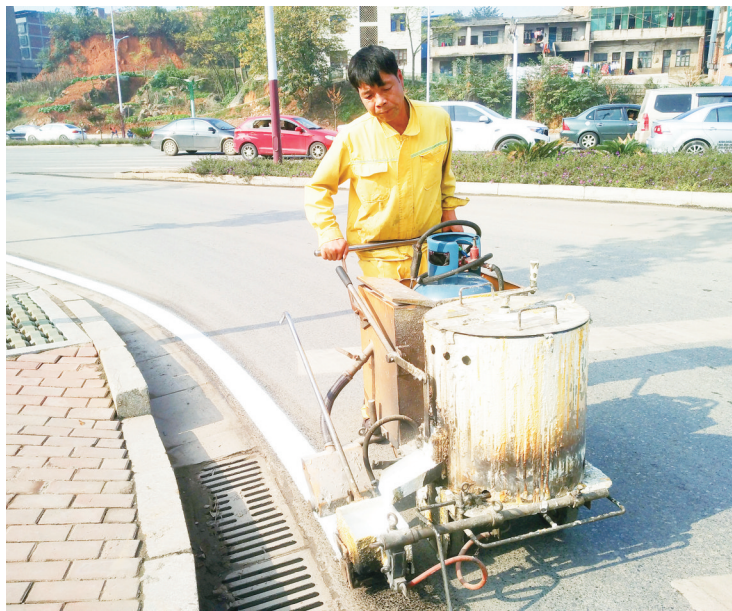
为了保证道路标线清晰,市交警支队设施大队组织施工人员对大祥立交至桂花大桥之间路段的边线及不清晰标线进行补划。图为11月20日,施工人员正在大祥立交附近补划边线。 申兴刚 摄
