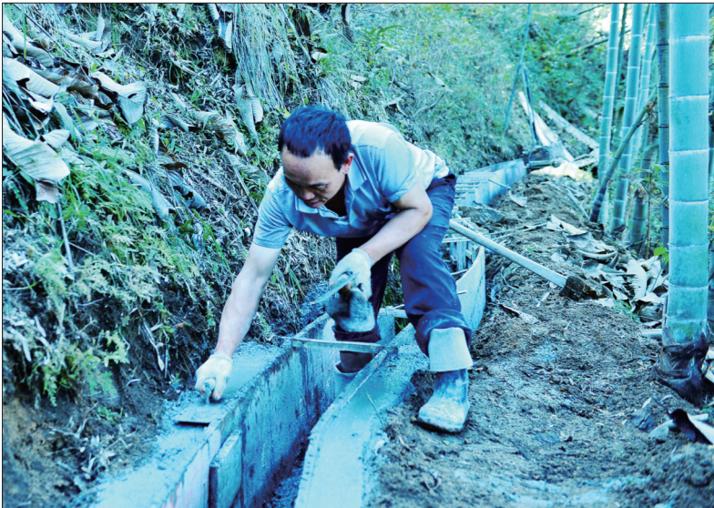
11月6日，隆回县小沙江镇分水村农民邹桂荣正在硬化绕山水圳。近年来，该镇积极争取上级“小五水”和水利综合改造资金，先后对分水、文明、白银等村农田水利设施进行全面改造，让昔日靠天耕作的2000多亩低产田，喝上了排灌自如的“自来水”，实现了旱涝保收。 杨敏华 贺上升 摄影报道
