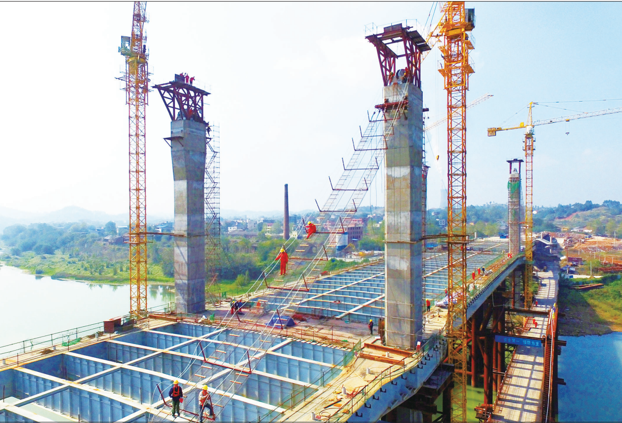
桂花大桥是我市西外环线上跨越资江的特大型桥梁，全长 542.13 米，主跨 120 米，宽 33.8 米，双向六车道，设计时速 80 公里，总投资 4.5 亿元。目前，桥梁上部结构西岸引桥浇筑箱梁现已完成，4 个 48 米高的索塔塔柱已经完工，主索鞍已经吊装到位，预计 2017 年 6 月可竣工通车。图为 11 月 4 日，施工中的桂花大桥。 申兴刚 摄
