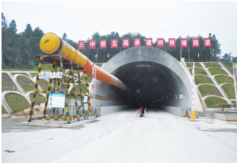
怀邵衡铁路邵阳段南岳庙拱桥铺隧道，全长3886米，为单洞双线隧道，施工工期33个月，预计2017年7月30日贯通。目前，该项目建设正顺利推进中。 马剑敏 摄
