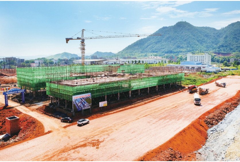
工业园金盆岭标准厂房项目建设现场 肖鸣学摄
