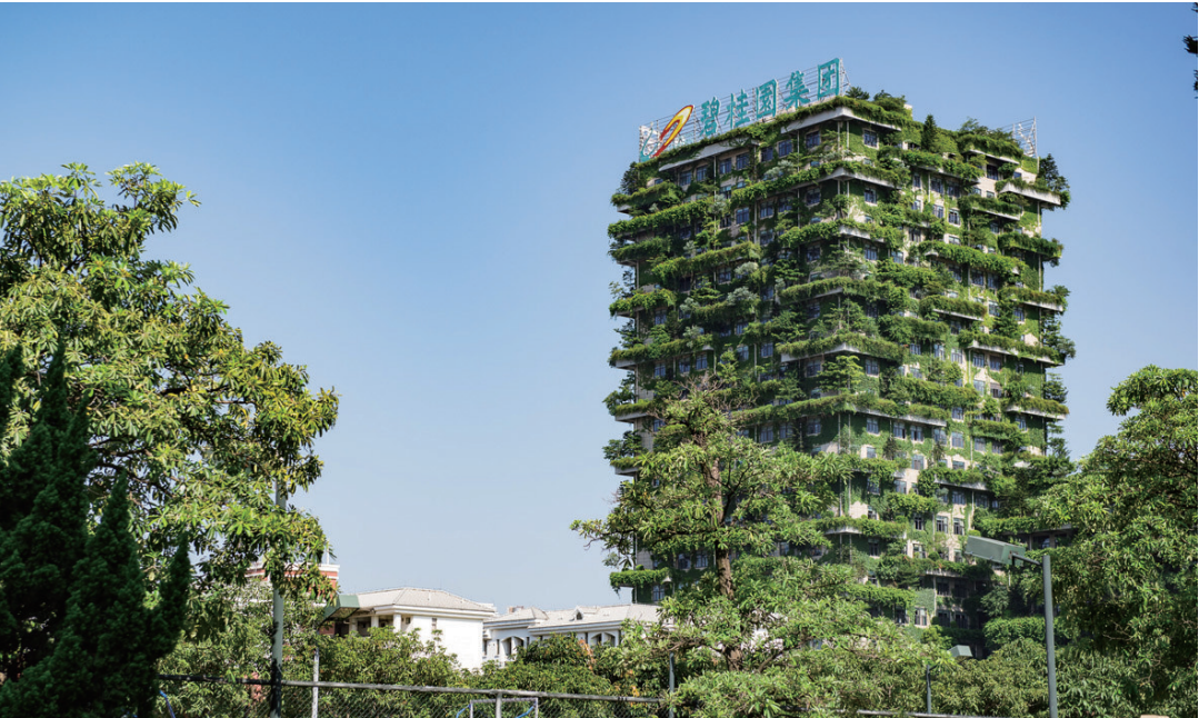
绿色建筑标杆——碧桂园集团总部大楼
