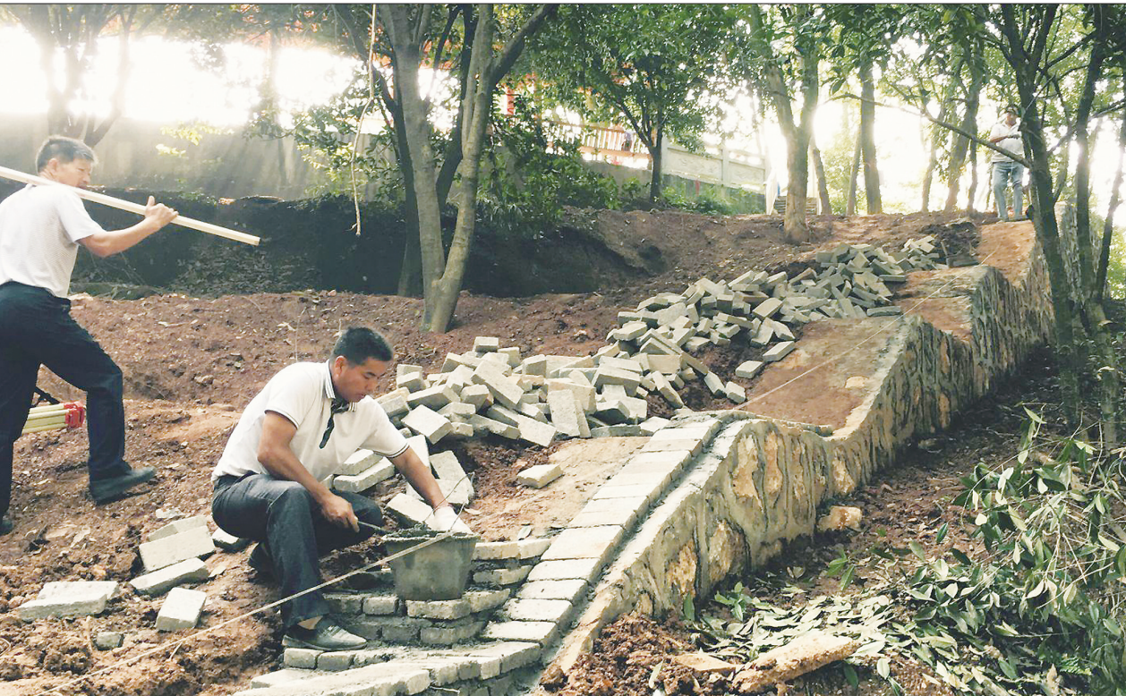
7月11日,新邵县赛双清公园提质改造项目施工现场,施工人员正在铺设游道。该项目总投资近800万元,工程内容包括景观工程和园林绿化工程建设、灯化亮化、山体滑坡治理以及建筑物立面改造等。工程于今年4月动工,预计今年年底竣工。 杨敏华 杨能广 摄影报道
