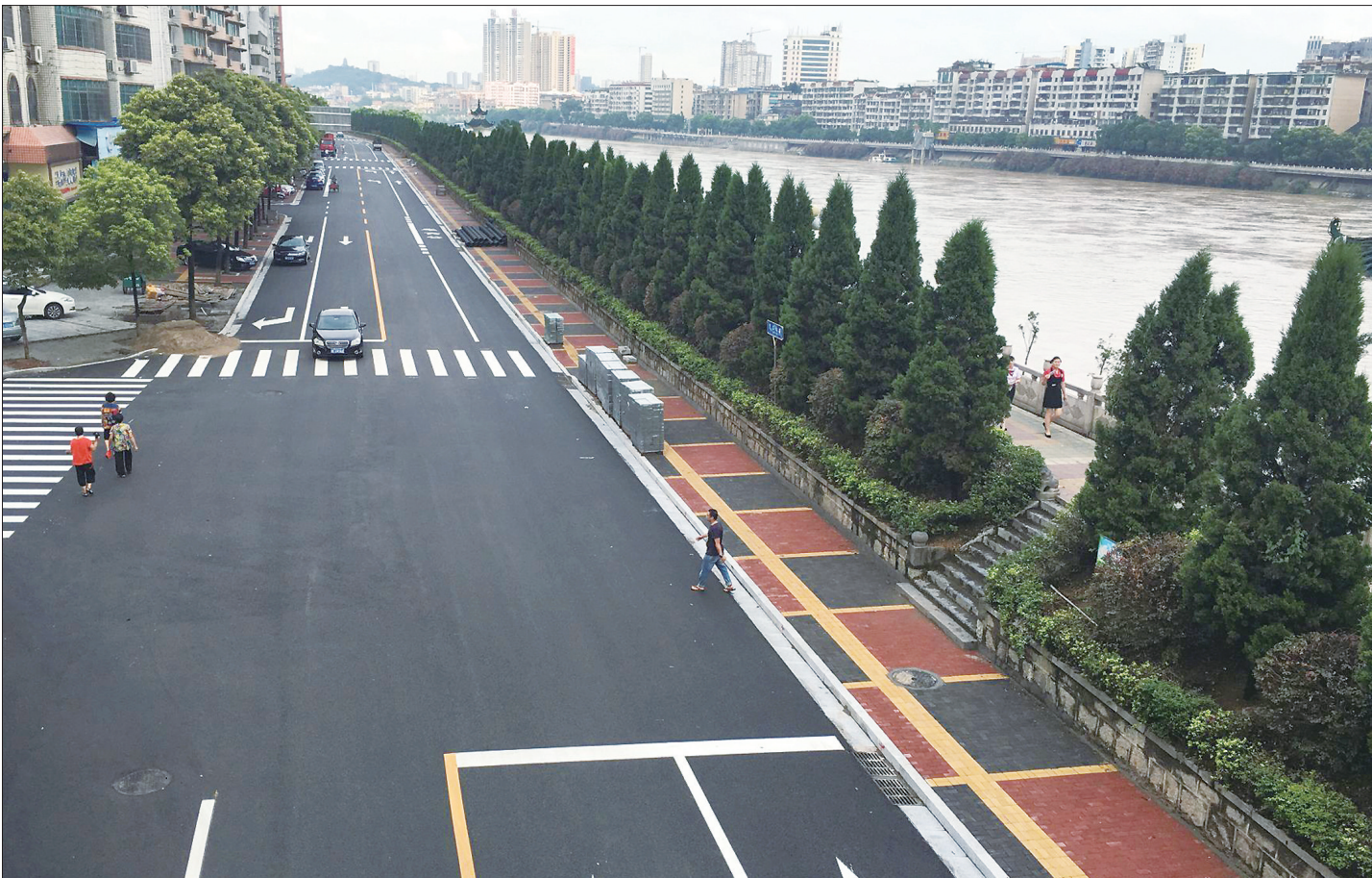
市区资江北路通过6个多月的提质改造后，于上月底完工并恢复通车。该路段东起资江一桥下，西至宝江路，约3公里，路面进行了“白加黑”摊铺沥青混凝土改造，道路排水、人行道板、照明等都进行改造和升级。图为提质改造后的路面通畅整洁。
