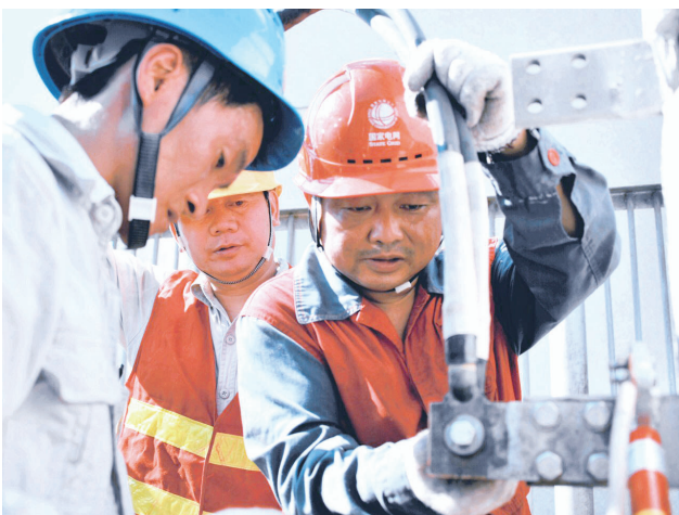
王柯(右一)与电力检修人员在进行消缺工作。刘元辉 摄
