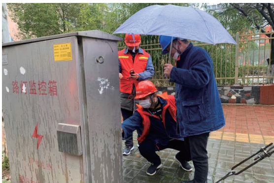
党员服务队进行紧急抢修作业。
