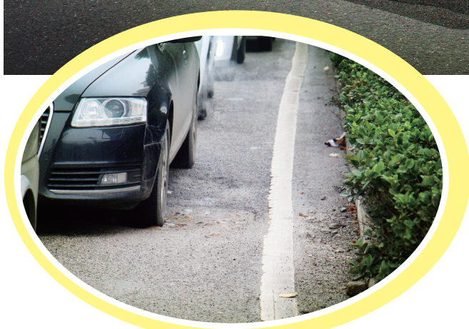
▲资江一桥桥头路面的大坑已用混凝土填补。
