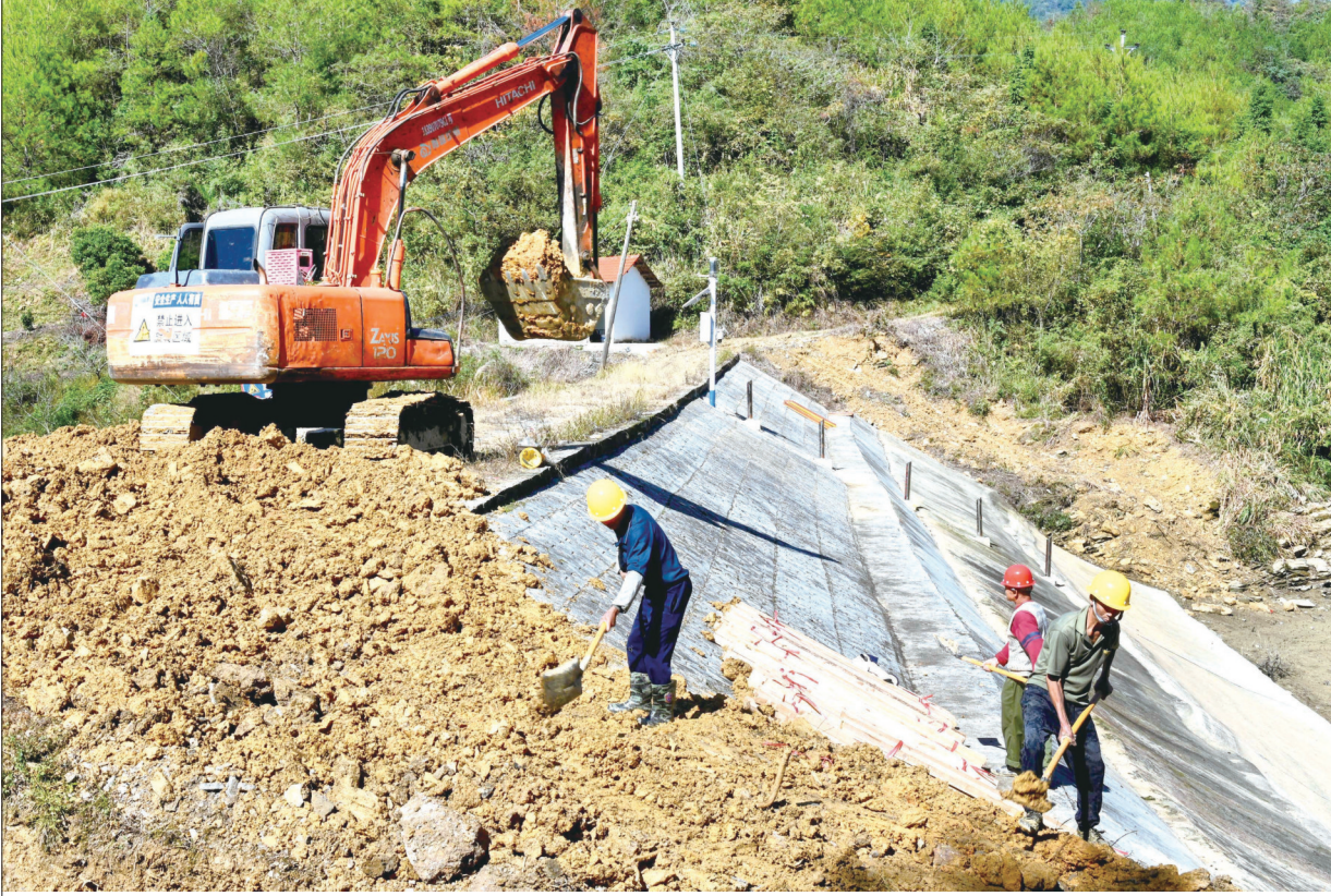
11月13日,绥宁县关峡苗族乡石家塘水库除险加固工程建设工地正在施工。立冬后,该县加大对中小型水库除险加固和农田水利基础设施建设力度,为来年农业生产和防汛抗早夯实基础。
