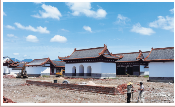
武冈博物馆建设现场。
