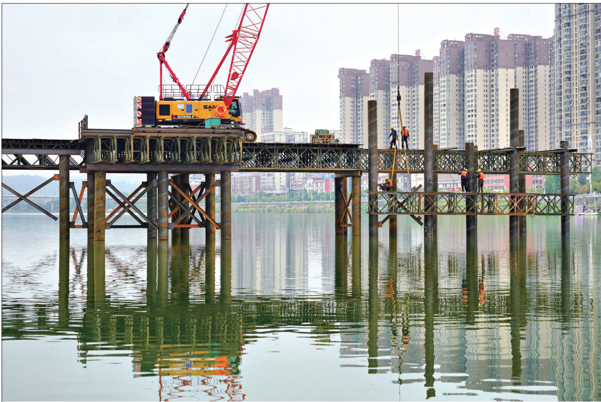
11月6日,隆回县青丰大桥桥梁工程建设正在有序进行。该大桥于10月开工,总投资1.96亿元,未来将成为连接隆回县城南北、缓解交通的关键通道。
