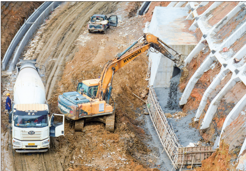
11月5日,在新宁县金石镇水头村新新高速公路二标段崆山互通枢纽收费站建设工地,施工人员正在浇筑混凝土护坡。据悉,该建设工程预计年底建成通车。 郑国华 摄
