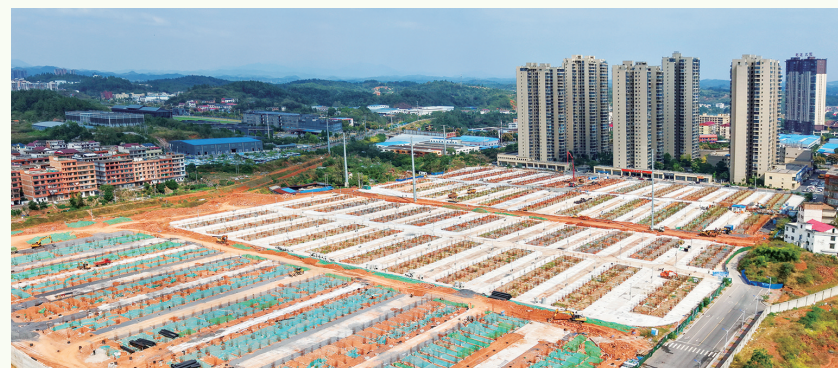
柘木安置小区项目。
