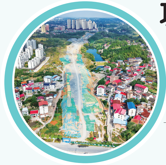
◀建设中的湖口井东路项目。
