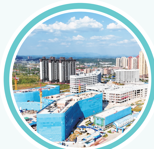
▲邵阳市宝庆医院建设项目。
