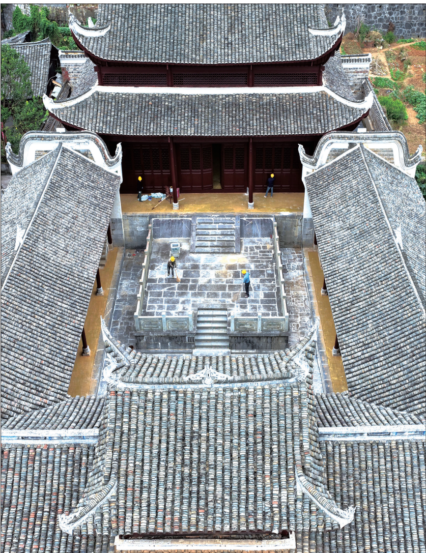
10月23日,工人在进行城步孔圣庙修缮项目扫尾工作。孔圣庙位于该县城区南侧,已有110余年历史,系湖南省文物保护单位。此次维修项目于2023年启动。
