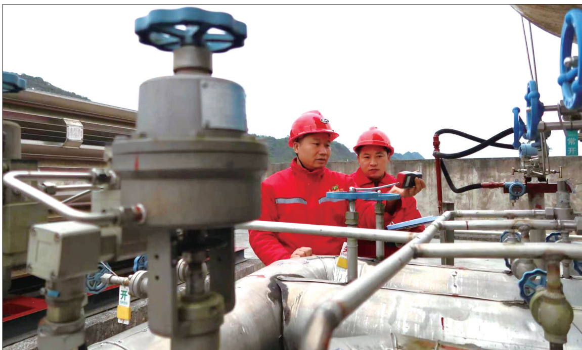
10月21日,城步新和兴天然气有限公司员工在检查燃气管道是否漏气。近期,骤然降温,城步苗族自治县强化供水、供电、供气保障力度,相关企业全力做好水、电、气的供给,加大设备检修、维护频次,确保人民群众生活不受影响。 严钦龙 熊建涛 摄影报道
