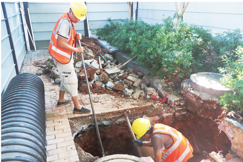
市政工人们在开挖修复市政管网。
