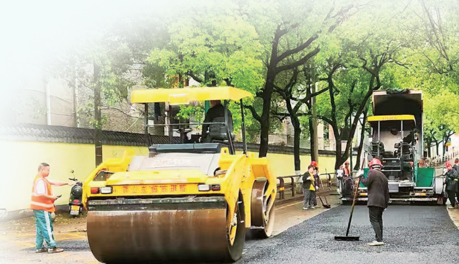
市市政维护事务中心在市区双清路摊铺沥青路面。
