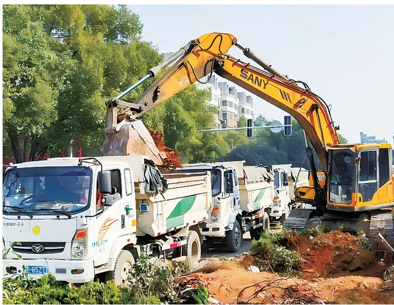
市市政维护事务中心在邵州路(铜铃东路—客村路)扩改项目现场进行施工。
