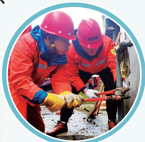
▲市燃气公司工作人员为小区改造燃气管道。 申兴刚 摄
