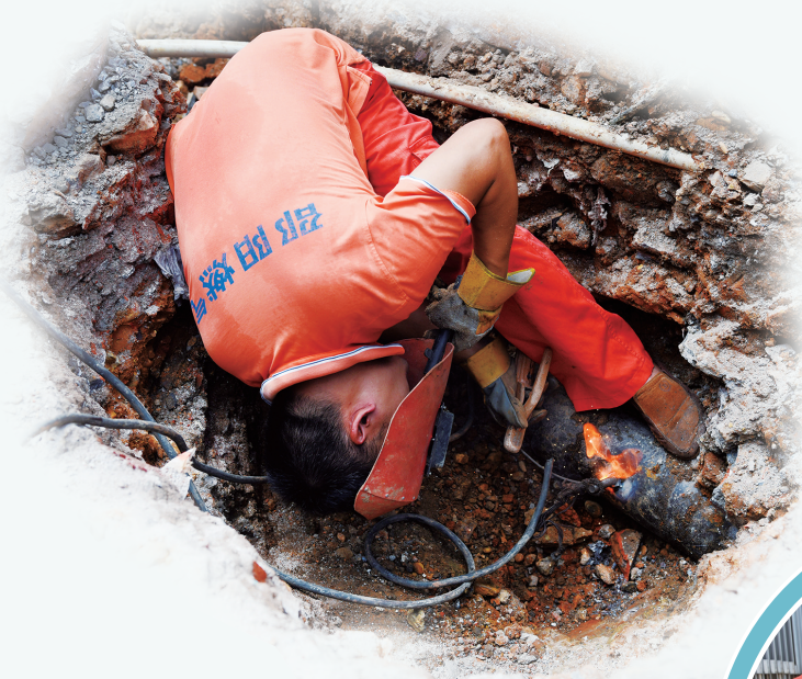
▲抢修人员对燃气管道进行抢修。 申兴刚 摄
