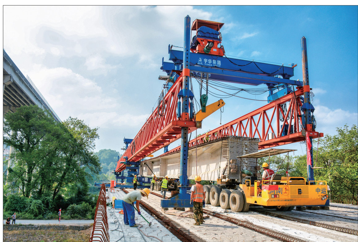
10月16日,在新宁县金石镇渡潭村虞家桥附近的夫夷江上,新新高速公路二标段崑山互通引线的虞家桥跨江高架大桥正进行第3跨第18片箱梁的铺架。该桥与G59呼北高速公路跨江高架桥并行,是该公路最后一座跨江高架桥,预计本月下旬完成箱梁铺架。
