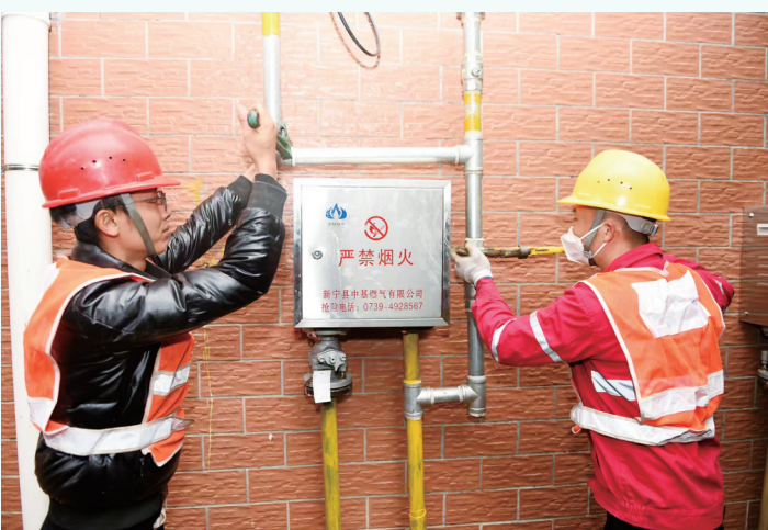
工作人员为小区改造燃气管道。
