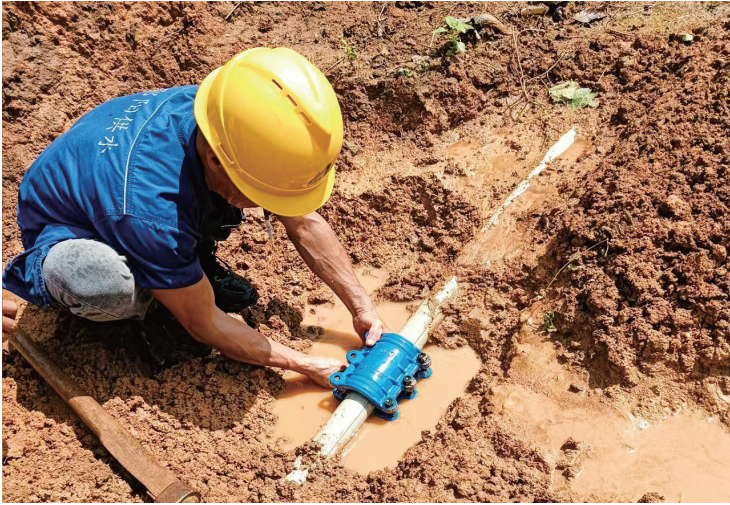
市自来水公司工作人员进行管道抢修。
