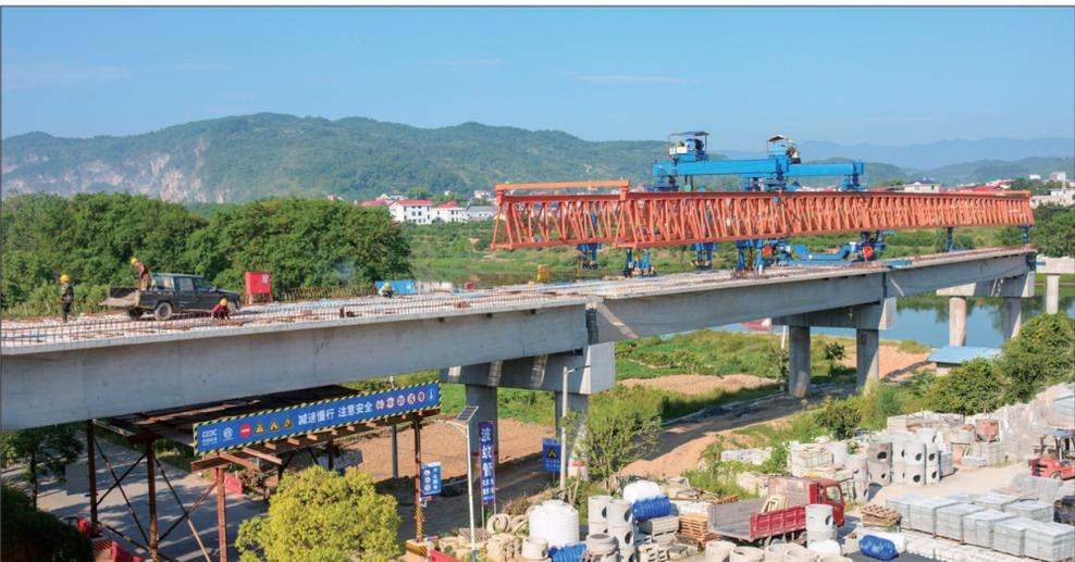
9月16日，在新宁县金石镇夫夷江上，新新高速公路二标段互通枢纽引线跨江大桥正在进行箱梁铺设。该桥长360米，桥面宽10米，预计本月底完工。目前，全线工程已进入路面摊铺阶段。
