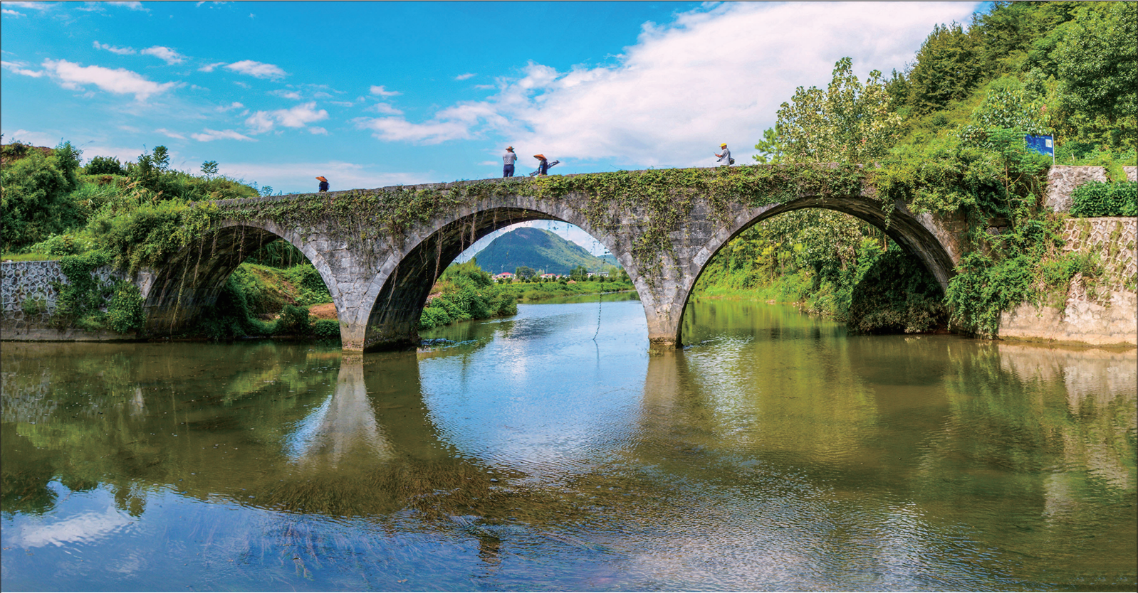
9月12日,摄影爱好者在新宁县安山乡滩底村的百年石拱桥上拍照打卡。据当地老人介绍,该桥名为“七路桥”,为三孔石拱结构,长20米、宽4米,可通行小轿车,至今已有百余年历史,桥体保存完好。它是连接安山乡花桥、车头、滩头等村与清江桥乡冻江村的重要通道,也是该县境内现存保存最完整、石砌工艺水平最高的百年古石桥。
