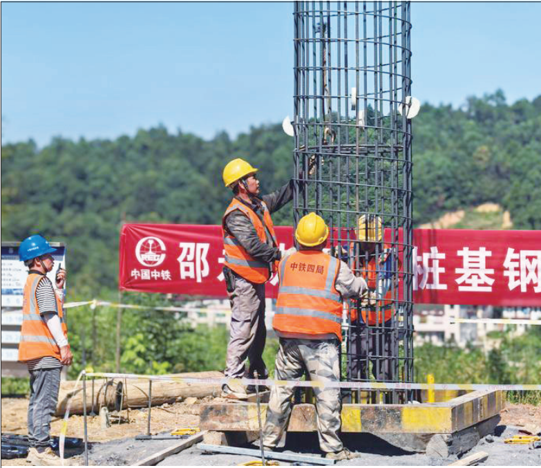
8月25日,在中铁四局邵永铁路1标段施工现场,施工人員正在全神贯注地进行桥梁桩基钢筋笼连接工序操作。当天,邵永铁路举办桥梁桩基钢筋笼连接工序质量比武,全面检验施工团队的工艺流程掌握、质量控制水平和协同作业能力。邵阳日报记者 刘波 通讯员 汪语嫣 赵成斌 摄影报道
