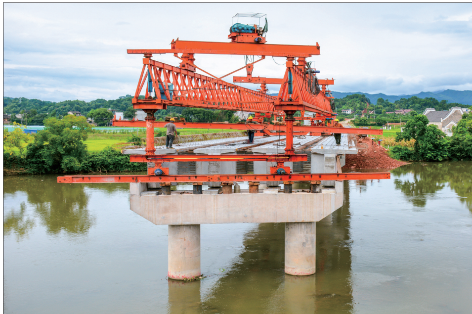
8月7日,新宁县金石镇柳山村,施工人员在江黄公路柳山大桥铺设梁箱。作为连接县城与金石、水庙、麻林、黄金四个乡镇的唯一县道,该桥宽10米、长120米,现已完成3跨铺设。
