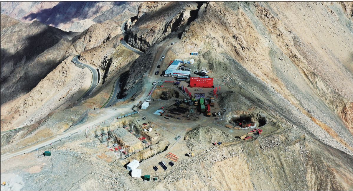
图为6月21日在青海冷湖天文观测研究基地拍摄的望远镜项目建设启动现场(无人机照片)。
